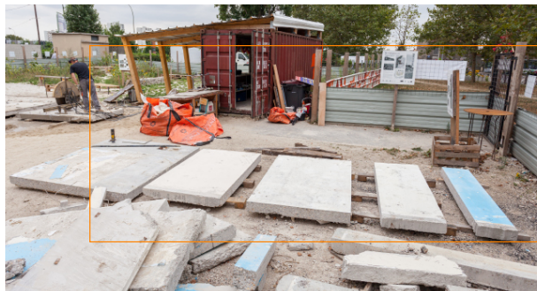
Le chantier de la Fabrique du Clos, une expérimentation du réemploi par Bellastock
